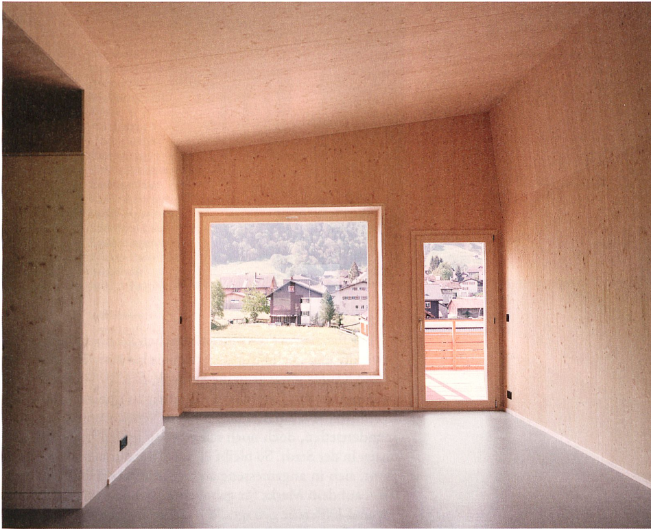
Das Sheddach als Referenz zum Industriebau stuft im Inneren die Raumhöhen der Wohn- und Esszonen.
