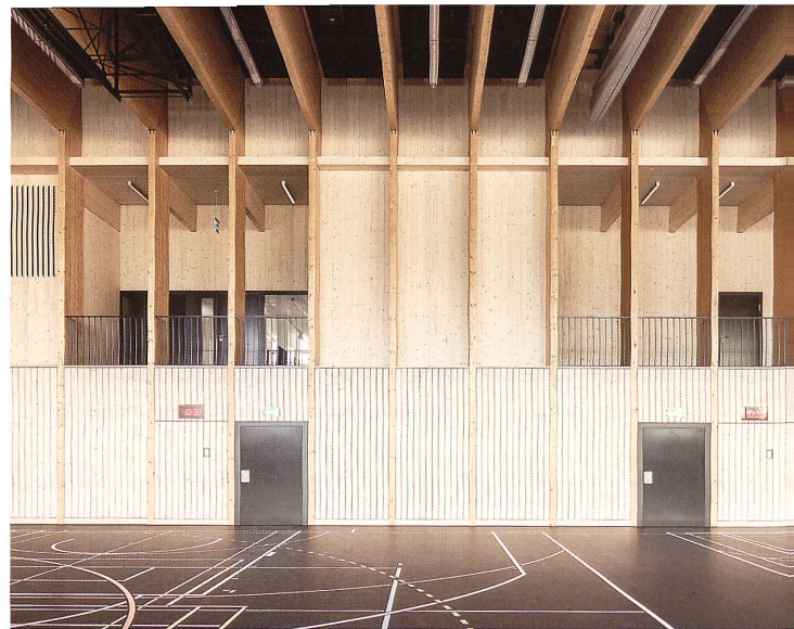
Die filigrane Tragstruktur mit parallelen Zweigelenrahmen gliedert die Innenräume
