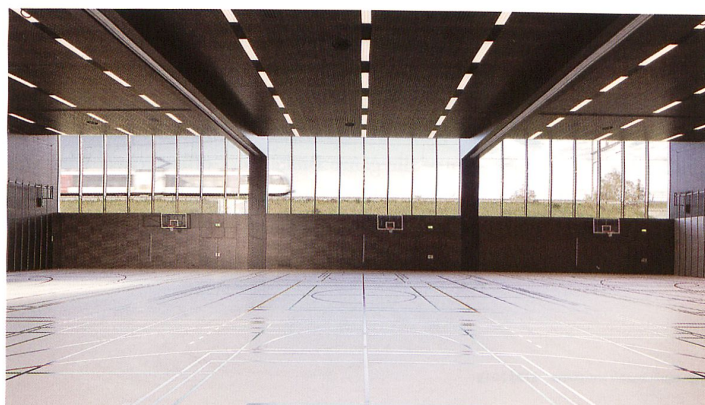
Nur zwei Trägerpaare tragen das Hallendach
