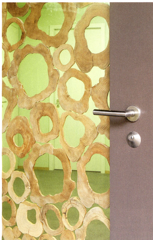
Das lichtdurchlässige Türornament aus computersortierten Eibenquerschnitten entwickelten Yuko Ishizu und Evi Xexaki mit Achilleas Xydis an der Professur für CAAD der ETH Zürich.
