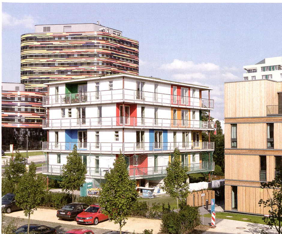
Hamburg-Wilhelmsburg: Das Haus zum Selbstausbau, ein Vorzeigeprojekt der IBA Hamburg, nennt sich «Grundbau und Siedler». In ein Betongerüst mit Erschliessungskern und Stützen nisten sich die Bewohner mit individuellen Grundrissen ein. Bild: IBA Hamburg, Bernadette Grimmenstein
