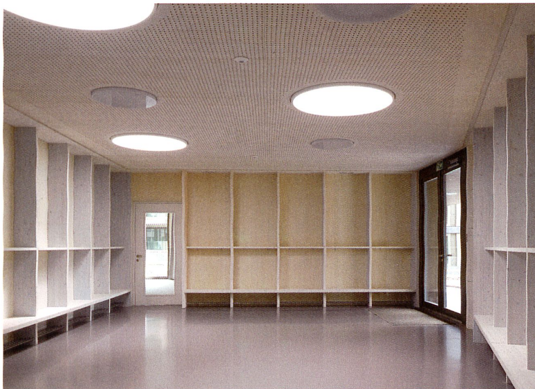
Kindergarten in Bern: Sprechende Holzkonstruktion aussen wie innen: Kassettierte Fassaden aussen und tragende Pfosten in der Garderobe. Bilder: Dominique Uldry
