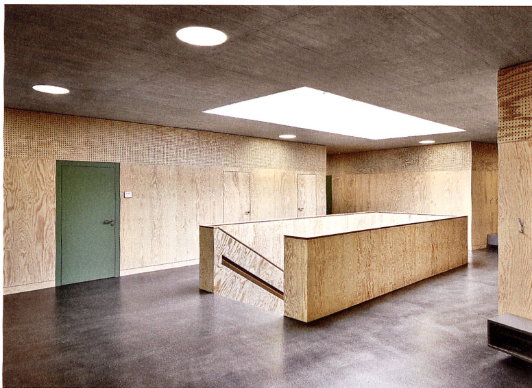
Kindergarten in Aadorf: Der Baukörper mit dem feinen Relief ist innen mit geöltem Seekiefer-Sperrholz ausgeschlagen. Fluchtwege direkt ins Freie erlauben die Bespielung der Erschliessungszone. Bilder: José Hevia
