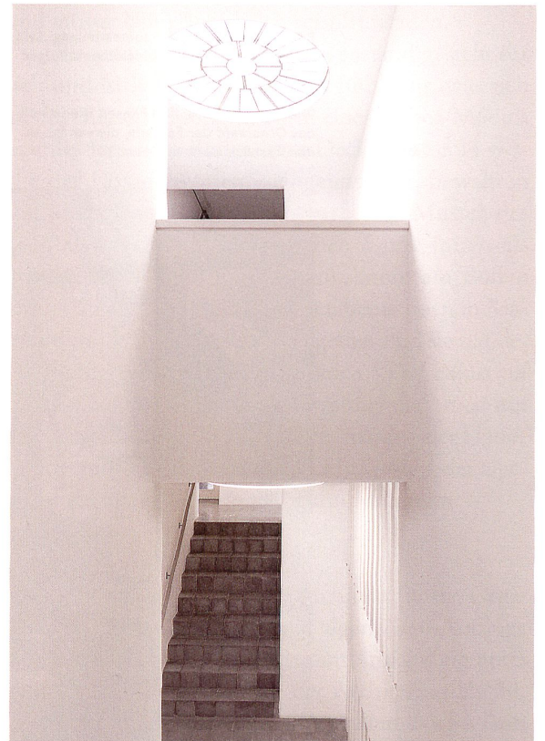
Der Erschliessungsraum mit sich kreuzenden Treppen in der Gebäudemitte ist wie in arabischen Häusern von oben belichtet.
