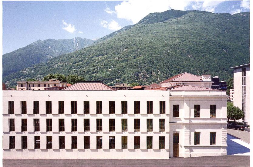
Die neue Fassade in weissem Beton misst sich unaufdringlich mit der neoklassizistischen Teilung des Altbaus.
