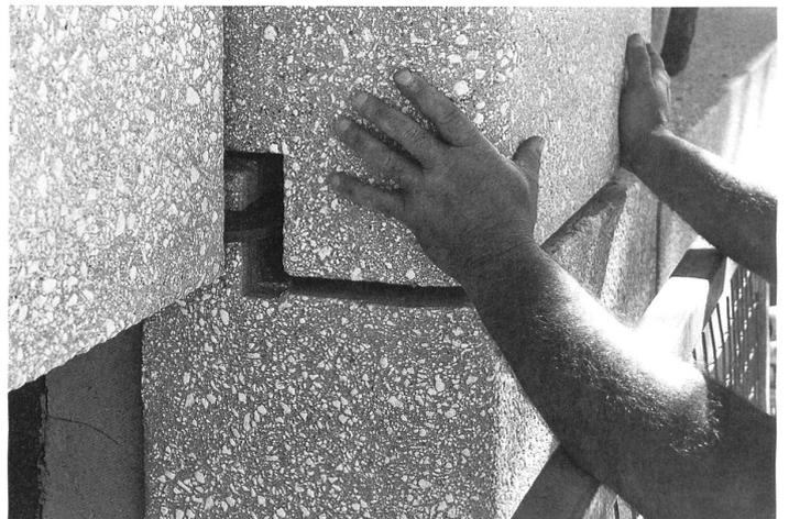
Eine der Schalungsmatrizen, im Bereich der Lisenen selber als glatter Zementkörper ausgeführt. Für die Stellen mit nachträglich starker Sandstrahl-Bearbeitung wurde eine herkömmliche Stahlschalung verwendet. Die komplexe Geometrie der Elemente wird deutlich in der mehrfach verschnittenen Geometrie der Schalung und entsprechend aufwändigen, hybriden Konstruktionsweise.
