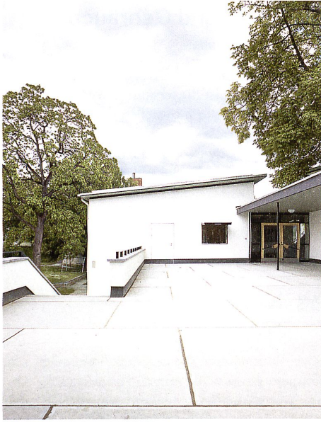
Hebelschulhaus Basel: Bildgetreue Sanierung im Geist der ursprünglichen Erbauer. → S. 80 Bild: Ruedi Walti
