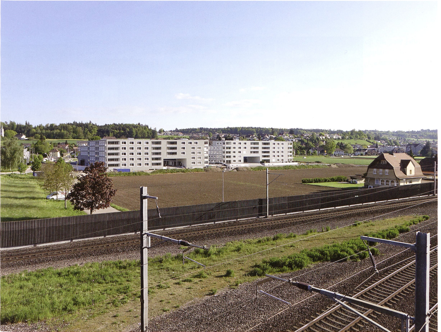
Städtische Dichte inmitten grüner Wiesen: Die ersten Neubauten im Quartier «Breitenpark» sind Blockrandtypen und zeigen zum künftigen Park fünf Geschosse.
