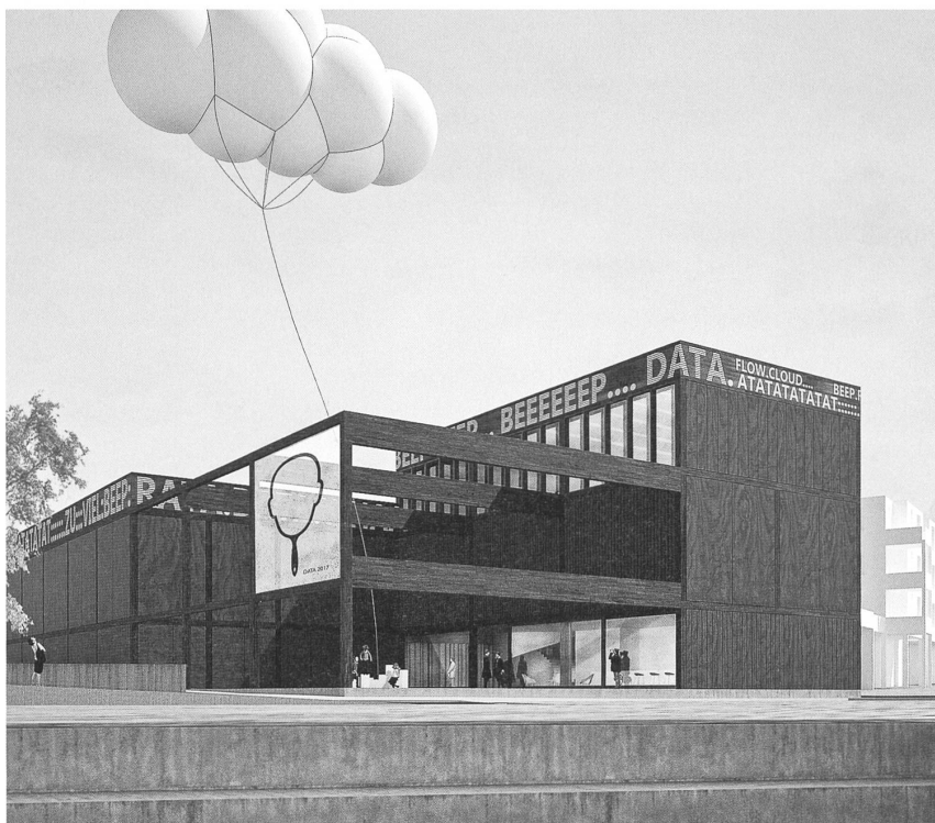
Das Siegerprojekt von pool Architekten: Die Holzrahmenkonstruktion differenziert Ausstellung und Verwaltung und umschliesst im Eingangsbereich eine frei bespielbare, offene «Gegenwartsbühne». Der Neubau liegt direkt am Bahnhof Lenzburg.
