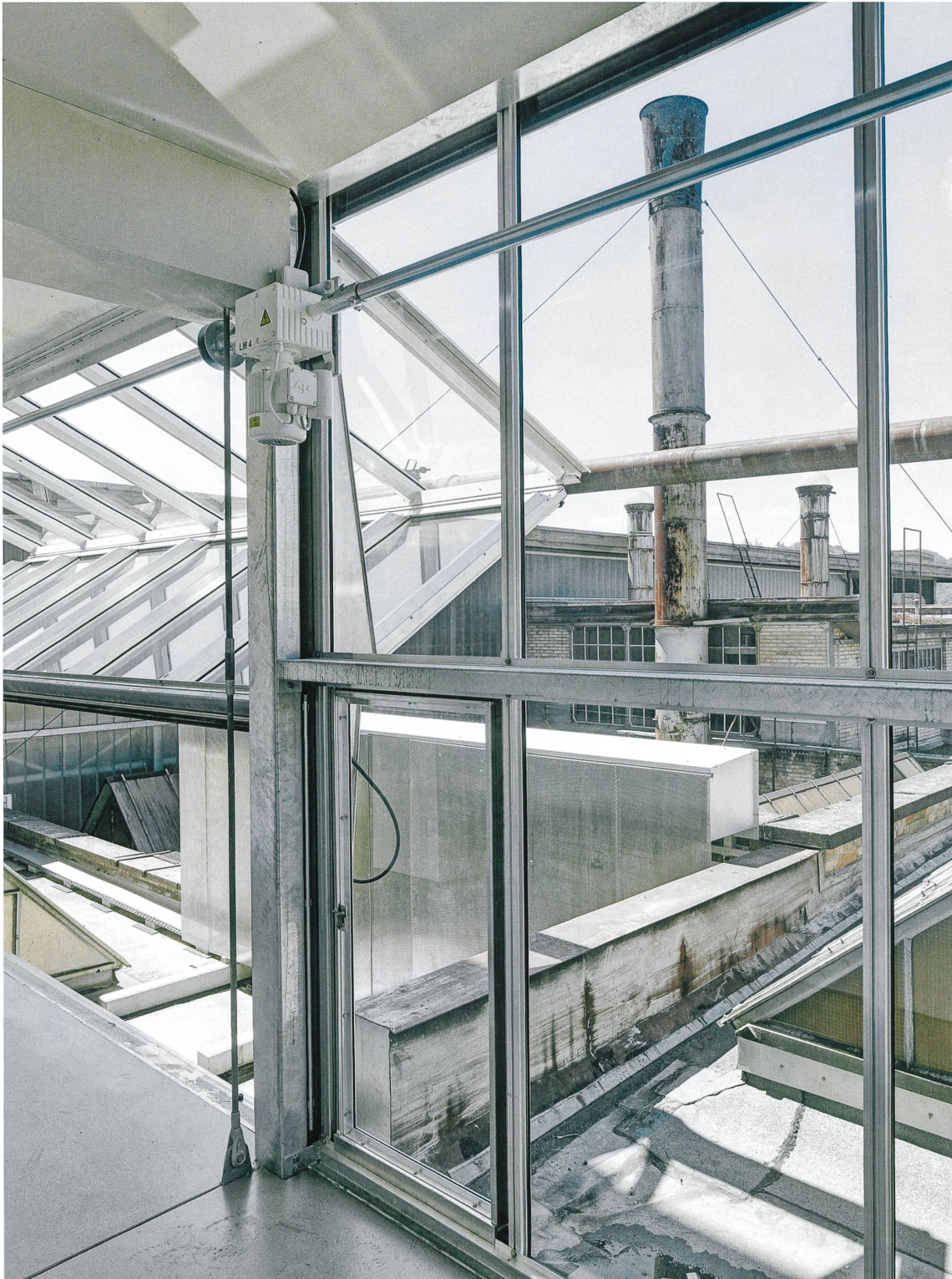
Der Korridor im 2. Obergeschoss wird über eine sogenannte Portefeuille-Verglasung belichtet und belüftet. Ihr Knick nimmt Bezüge zum Glasdach der Halle auf.
