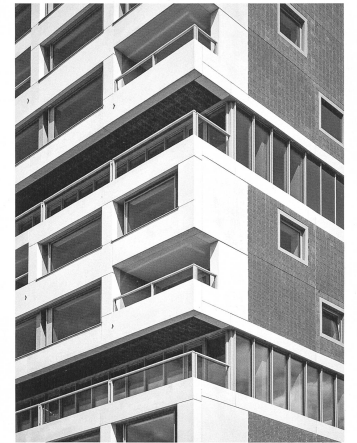
Die Fassaden sind elementar gegliedert und repräsentieren die verborgene Platten-Scheiben-Tragstruktur, aus der auch die Teilierung des Körpers hervorgeht.
