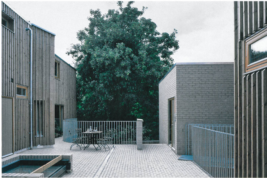
Die Differenzierung halbautonomer Häuser über das Material – und erst recht mit Holz! – ist im Land der kleinen, normierten Backsteinhäuser eine selten gesehene Fertigkeit von Architekten. Bild: Ioana Marinescu
