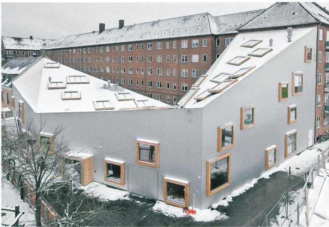
Fünfte Fassade und ein reiches Innenleben.
