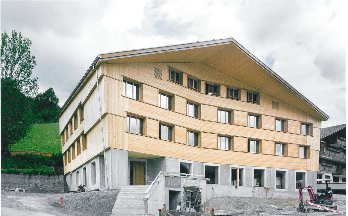
Der wuchtige Baukörper der Jugendherberge in Saanen ist dem Saanenländer Bauernhaus verpflichtet. Die Unterscheidung von Seiten- und Hauptfassade entspricht diesem auch konzeptionell. Bild: Alexander Gempeler
