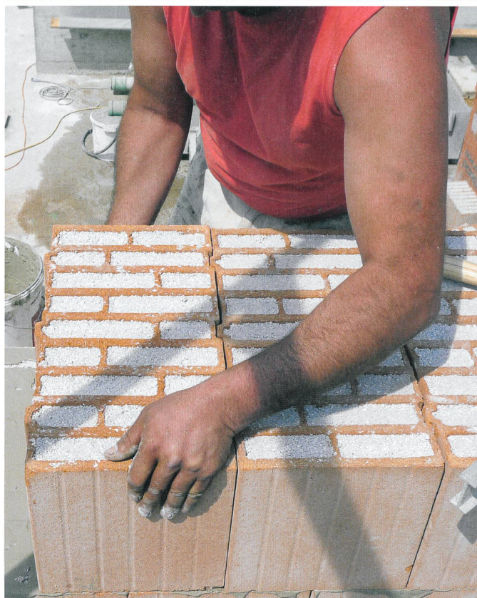
Die Baustelle lässt den Cluster-Grundriss mit Satellitenwohnungen und den versteifenden Kern in der Mitte erkennen (Bild oben: Johannes Marfurt). Quer versetztes Einsteinsmauerwerk mit Perlitfüllung (Bild: Katinka Corts)
