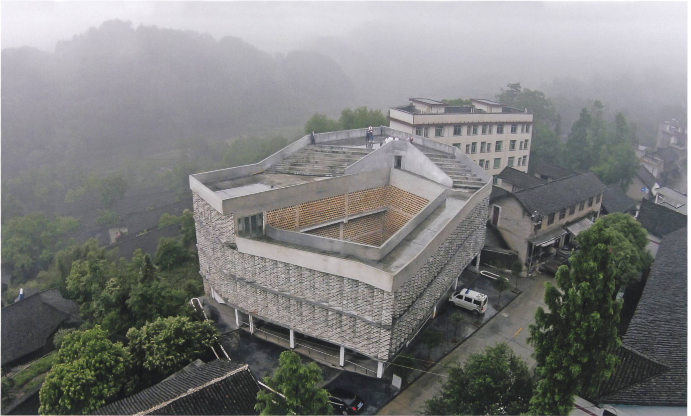
Spital Andong: Offen und einladend, mit einer Rampe als Erschliessung und einer Hülle aus vorfabrizierten, braunen Betonguss-Elementen.
