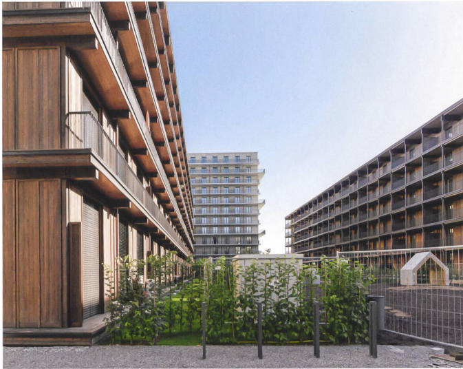
Der Gartenraum zwischen den Langhäusern kurz vor der Fertigstellung.
