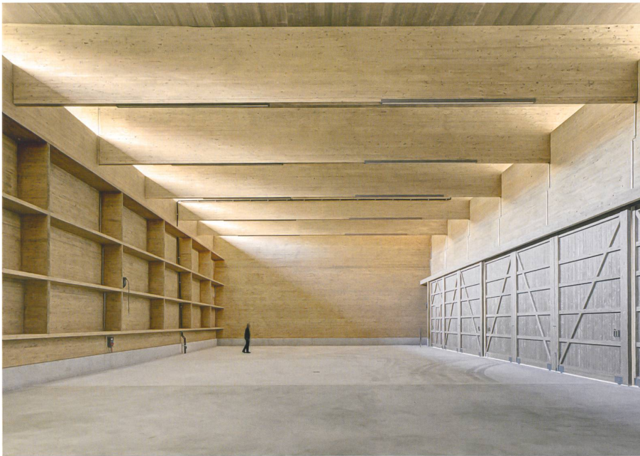
Die schlanken Dachbinder prägen die hohe Werkhalle des Wasserbauwerkhofs Neugut bei Andelfingen
