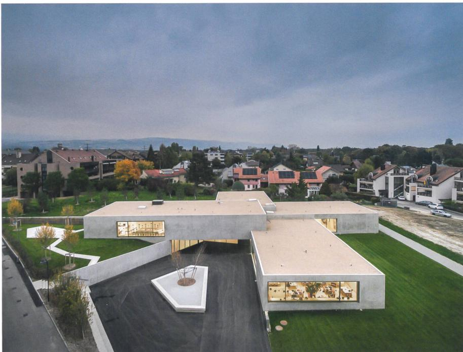
Vier einzelne Gebäudeflügel, in der Höhe um je ein Drittelgeschoss versetzt, verzahnen sich zu einer kreuzförmigen Anlage. Mensa und Hort bilden den obersten Flügel, der die Eingangshalle überspannt.
