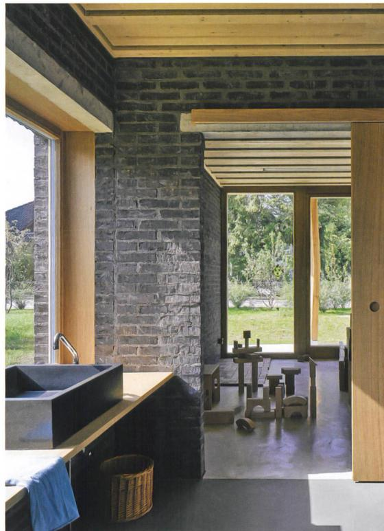
Tragen, Lasten und Fügen: dunkler Klinker für die Wände, Holzbalken für die Decken und Schreinerarbeiten für die Einbauten.
