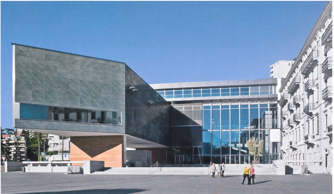
Das Museum MASI (links) und das verglaste Foyer des LAC fassen den öffentlichen Platz. Hinter der Fassade des Grand Hotel entstanden private Eigentumswohnungen.
