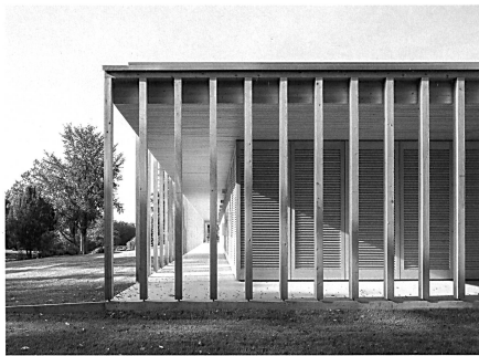
Je nach Achsbreite der umlaufenden Holzstützen werden Wege durch den Pavillon oder Ausblicke in die Parklandschaft des Bads freigespielt. Bild: Hanspeter Schless / Cukrowicz Nachbaur.
