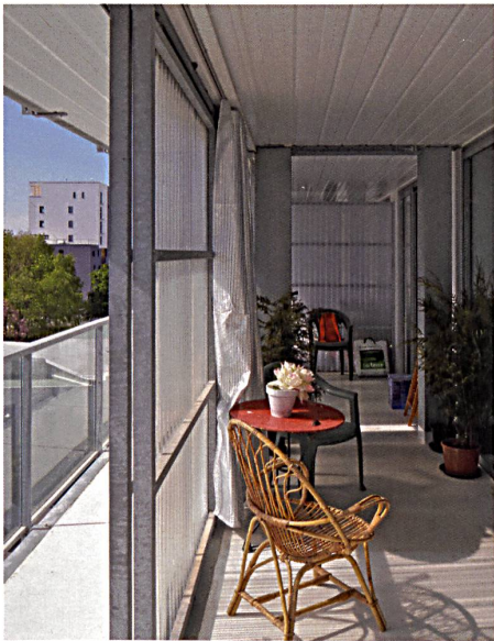
Räumlicher Mehrwert: Im bretonischen St-Nazaire verwendeten Lacaton & Vassal Stahl nicht nur für die Erweiterung des bestehenden Wohnturms, sondern auch für den Erweiterungsbau. → S. 32 Bild: Philippe Ruault
