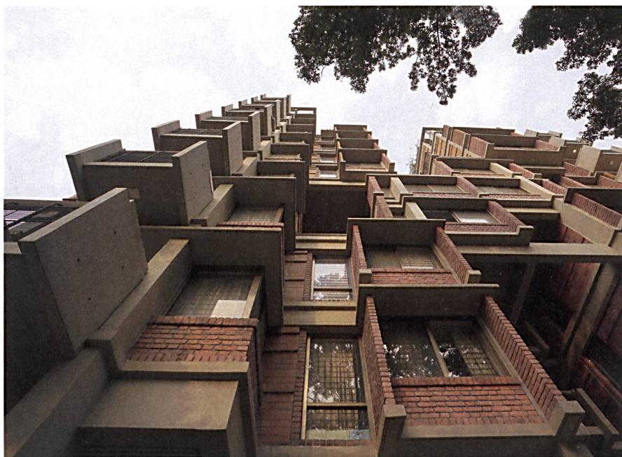
Low-tech-Ansatz für ein tropisches Hochhaus: Durch die Stapelung von pavillon-ähnlichen Grundmodulen wird die Eigenverschattung der Fassade wirksam erhöht. Die zerklüftete Grundrisskonfiguration fördert die natürliche Durchlüftung.
