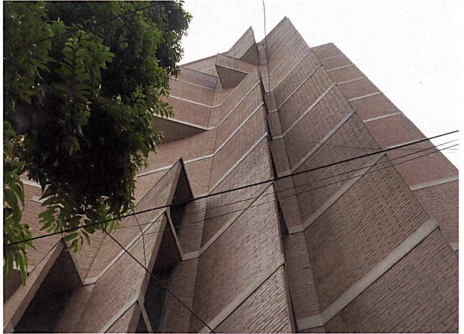
Eine kienenartige Backsteinkruste schützt die Innenräume vor direktem, gleisendem Sonnenlicht und vor dem Lärm der im Verkehrschaos ertrinkenden städtischen Hauptschlagader der Mirpur Road.
