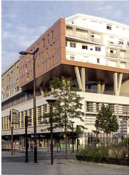
Über dem Lagerhaus Entrepôt Macdonald in Paris erhebt sich als Aufstockung ein ganzes Stadtquartier. Im Bild: Bauteil von Christian de Portzamparc. → S. 14 Bild: Thomas Mayer
