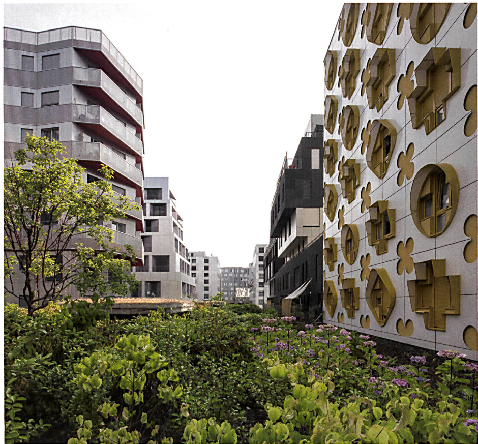
Zum Zwischenraum auf dem Dach des ehemaligen Entrepôts gab es weniger Einschränkungen; entstanden ist ein für Frankreich sehr typischer «Architektur-zoo». Links: Gigon/Guyer, dahinter Julien de Smedt; rechts Stéphane Maupin. Die Landschaftsarchitektur stammt von Michel Desvigne. Bild: Thomas Mayer
