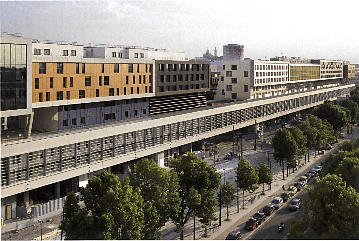
Auf der Nordseite, am Boulevard Macdonald ist das 650 Meter lange Lagerhaus noch gut zu erkennen; die neuen Aufbauten mussten sich zur Strasse hin an bestimmte Gestaltungsregeln halten. Bild: Eric Sempé
