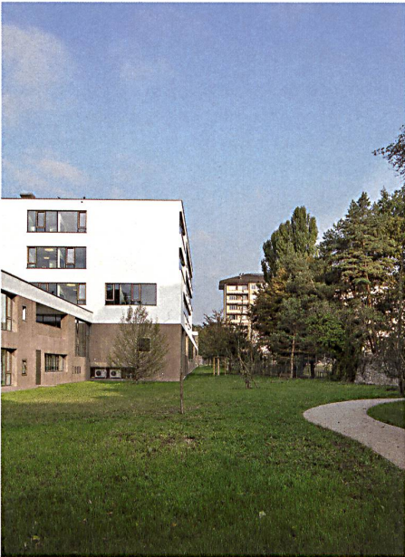
Das umsichtig gestaffelte Volumen der Quartierschule Chandieu in Genf schafft vielschichtige Verbindungen zwischen dem Quartier und dem Freiraum. → S. 70 Bild: Yves André
