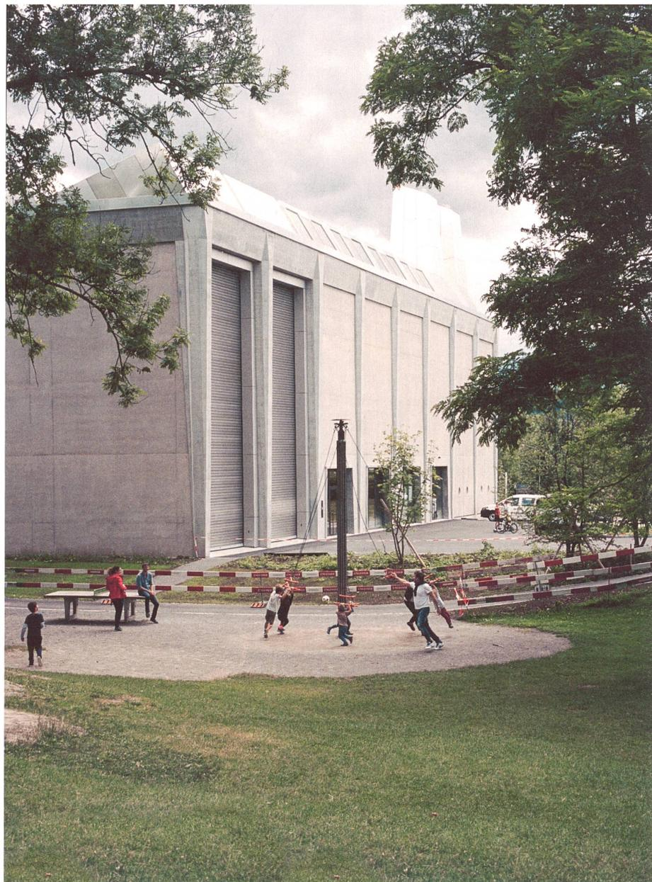
Technik im Park: Das sehnige Betongerüst mit Füllungen aus Recyclingbeton mit Ziegelschrotbeimischung beherbergt ein Salzlager und zwei Ölbrenner-Kessel (Bild rechts), um die Spitzenlasten im Fernwärmenetz zu decken.
