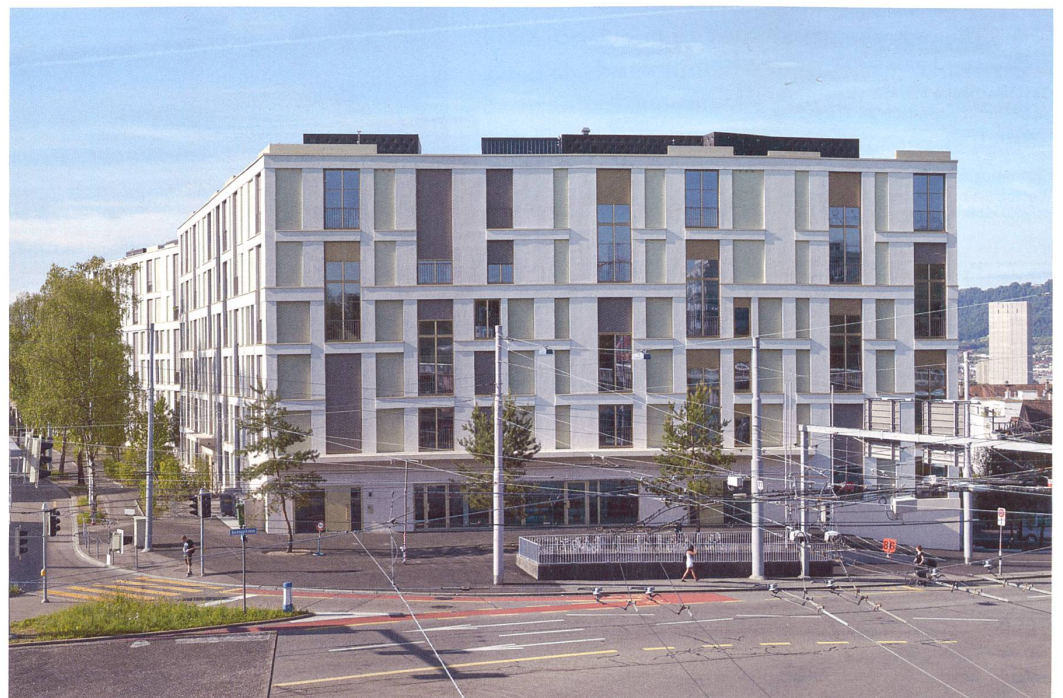
Im Innenhof (oben) türmen sich Balkone, um allen eine freie Aussicht zu bieten. Zum Verkehrskreisel am Bucheggplatz zeigt die Siedlung ein städtisches Gesicht. Bilder: Johannes Marburg
