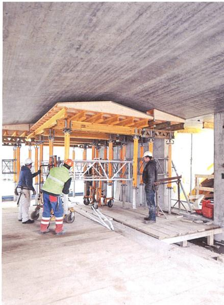
Die Schalung als Tempel: Abbau der Elemente, mittels derer die Beton-Faltdecken des St. Galler Bürogebäudes von Corinna Menn / Mark Ammann gegossen wurden. → S. 31
