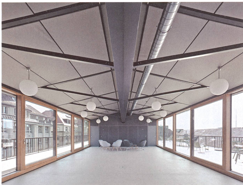
Den ebenfalls stützenfreien Aufenthaltsraum im Dachgeschoss überspannt ein fast 40 Meter langer Stahlträger in Längsrichtung (Bild oben). In den Bürogeschossen ordnen sich auch die Sitzungszimmer der Primärstruktur unter und stehen wie Möbel mit Luft zur Decke im Raum (unten).
