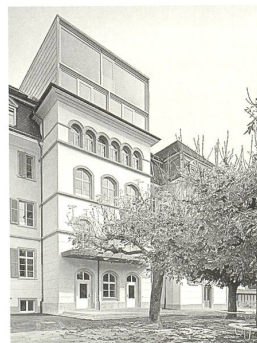
Beda Dillier Restaurierung und Umbau Schulhaus Konvikt Sarnen, 2013 Architekturbüro Beda Dillier Bild: Roger Frei
