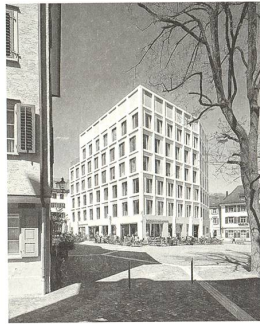
Patric Allemann Rathaus Altstätten SG, 2015 Allemann Bauer Eigenmann Architekten, Zürich Bild: Hannes Henz
