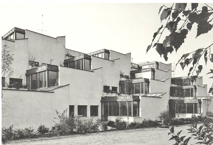
Oben: Jean-Claude Steinegger. Unten: Gestaffelte Raumcluster mit Gruppenraum und Terrasse charakterisieren die Realschule Bützenen – rückwärtig reagiert sie mit einer harten Wand auf den Lärm der nie gebauten Umfahrungsstrasse. Bilder: Hartmann Architekten
