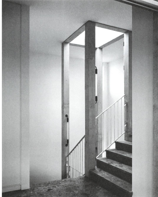
Die Einfassungen der Fenster sind aus Dämmbeton, die Wandstücke dazwischen aus Einsteinmauerwerk.
