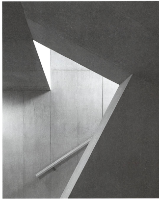
Fassade, Treppenhaukern und Eingangshallen der Maisonette-Wohnungen sind tragend. Bilder: Thomas Stöckli
