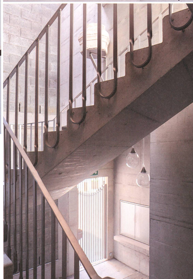
Verzahnung von Mauerwerk und zweischaligem Sichtbeton an der Seitenfassade.
