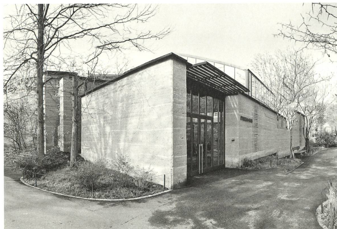
Oben: Peter Stiner (stehend, rechts) im Kreis seiner Kollegen im Zoo. Bild: Radek Rukat. Unten: Das Etoscha-Haus war 2001 ein Pionierbau in Stampflehm. Bild: Zoo Basel
