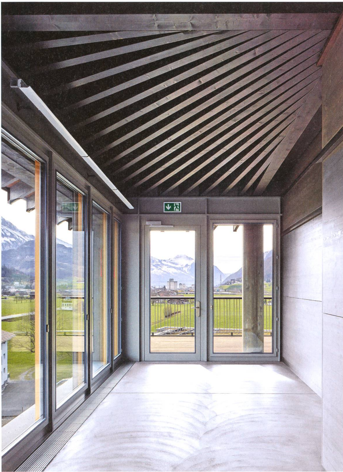
Die Dachkonstruktionen im hoch gelegenen Kundenbereich folgen bildhaft japanischer Architektur (Bild links oben) – aber auch einer ganz eigenen Logik des Überspannens: Als eine Kombination von Sprengwerk und Fachwerk-Ausleger für möglichst uneingeschränkte Aussicht im Verpflegungsraum (rechts) und in den Kursräumen (unten).
