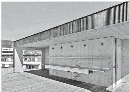
Die expressive Treppe auf der Hof- seite ist gleichzeitig Erschliessung und privater Aussenraum (oben). Die Aussenküche auf der Dachterrasse steht der ganzen Hausgemeinschaft zur Verfügung. Bilder: Dirk Weiss
