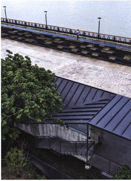
Atelier Deshaus aus Shanghai baut Häuser, deren Funktion manchmal alles andere als klar ist. → S. 61 Bild: Deshaus
