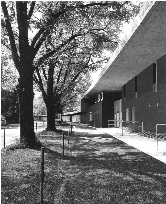
Strandbad Lido, Luzern (1999): Ein lang gespanntes, ausragendes Dach verankert das Strandbad im Stadt- und Landschaftsraum. Bilder: Ralph Eichenberger (oben), Jean-Pierre Grüter
