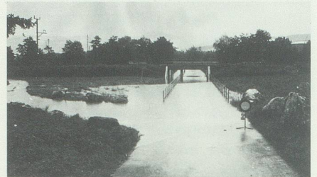
Juni und Juli: Die schweren Unwetter haben unübersehbare Folgen. Das Bild zeigt die überschwemmte Bahnunterführung Rohert bei Sennwald am Wochenende vom 18./19. Juli.
