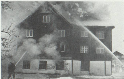
19. Januar: In Grabs brennt die ehemalige Teppichfabrik Ulrich Vetsch.
