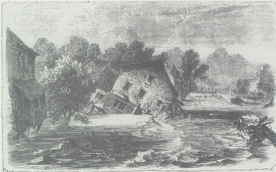
Eisenbahndammbruch bei Burgerau.
