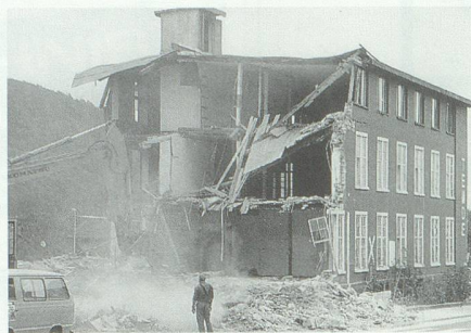
30. September: In Sevelen wird das alte Fabrikationsgebäude der Temde dem Erdboden gleichgemacht.
