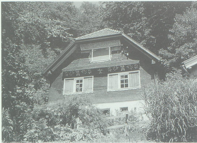
Abb. 14. Das alte Schulhaus Steig (Sevelerberg) von 1818. Zustand 1994.
