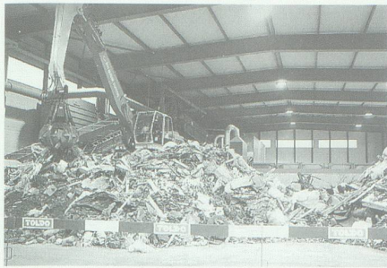
11. November: In Sennwald wird die Sortieranlage der Baurest Rhein AG offiziell in Betrieb genommen.
