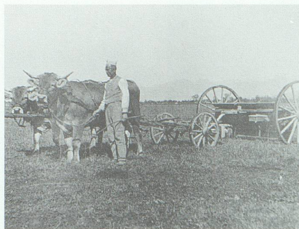
Abb. 7. Bereits in den zwanziger Jahren wurde in der Strafanstalt Saxerriet diese Kunstdünger-Streumaschine eingesetzt.
