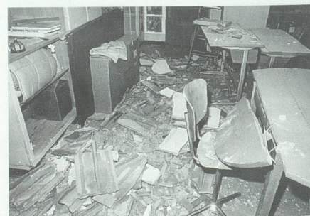
16. Januar: In einem Zimmer des Schulhauses Feld in Azmoos stürzt der Decken-Unterputz ein.
