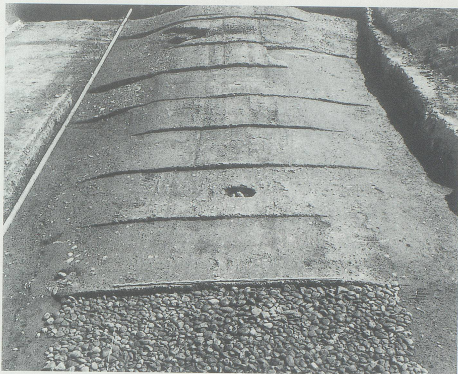
Abb. 3. Arch BE, Römerstrasse. Treppenartig freigelegte Fahrhahnoberflächen mit Karrenspuren. Im Vordergrund die Steinkofferung. Aus Bacher/Ramseyer 1994, S. 379.
