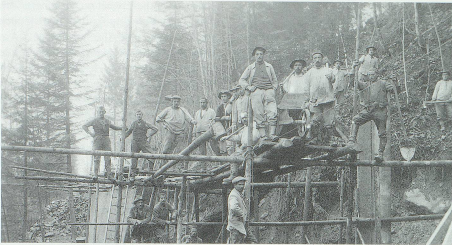
Abb. 23. Hinter der Badweid, gegen die Tobelsäge hinab: Ansicht vom Bau eines schwierigen Teilstücks der Güterstrasse Lehn-Tobelsäge, die nach 1926 erstellt wurde. Auf dem Gerüst vorn in der Mitte stehend «s Fritze Heiri», Stütli (1900 bis 1980). Bild bei Heinrich Lippuner-Eggenberger, Wachsbleichstrasse, Rorschach.
