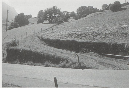
Abb. 12. Am Schnittpunkt der Strasse mit der Amatüeggass (oberhalb des neuen Schulhauses) zeugt eine sorgfältig gestaltete Anfahrt mit schönen Bruchsteinmauern von der handwerklichen Kunst der Strassenbauer vor 100 Jahren. Bild 1996: Hans Stricker, Leversberg, Grabs.
